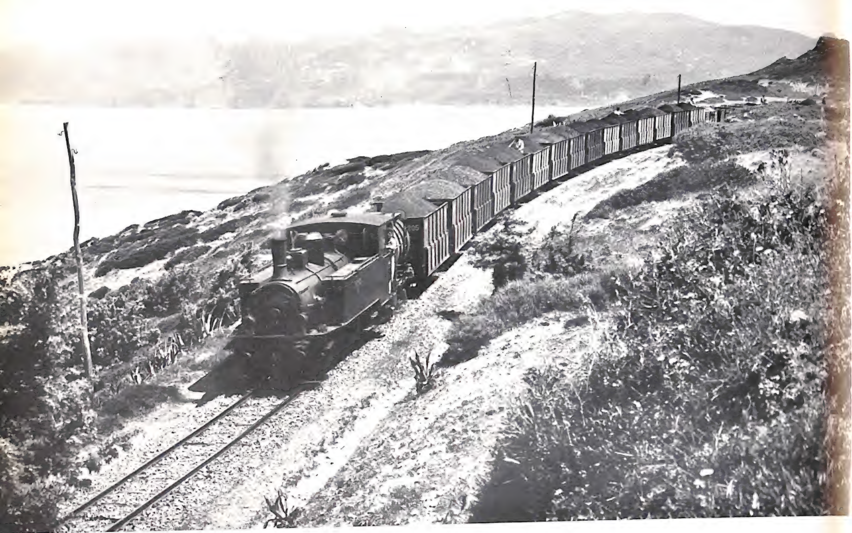
Ferrovia privata Monteponi-Portovesme - Treno in viaggio fra la Miniera di Terras Collu e Portovesme.
